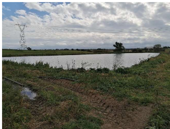
Figura 6.4 – Vista para uma das lagoas de retenção de efluentes
