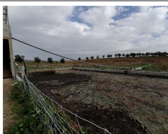
Figura 8.1 – Tanque de Receção
