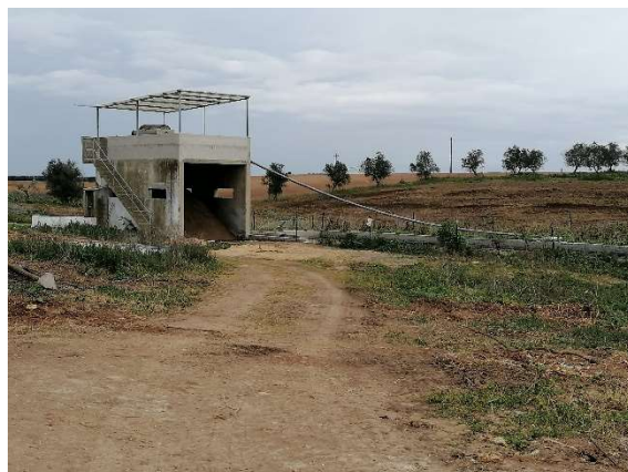
Figura 6.3 – Vista para o separador de sólidos
