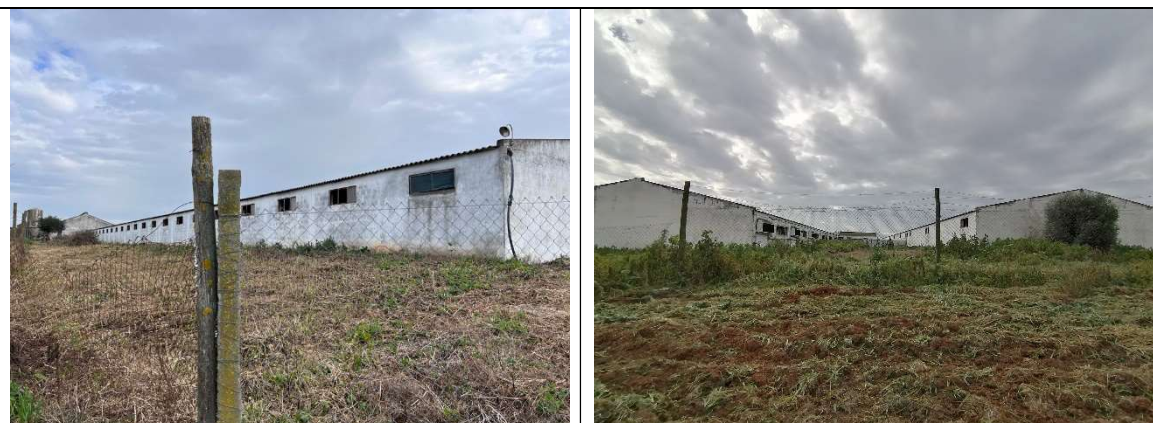
Figura 6.1 e Figura 6.2 – Vista exterior dos pavilhões de produção
