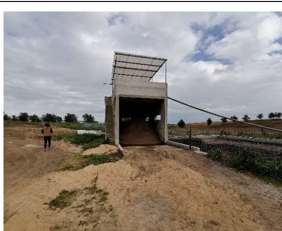
Figura 8.2 – Separador de Sólidos
